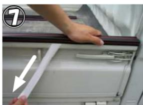
剥離紙を引っ張り出しながら、プロテクターを手で押さえていきます。(継ぎ目のところは注意して下さい)
