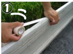
取付部の汚れ、油脂等を除去し、両面テープを貼り付けます。
