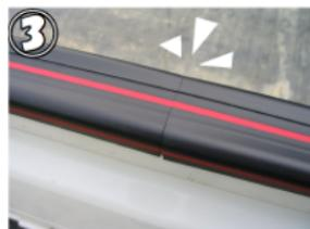
プロテクターの継ぎ目はすき間ができないように突き合わせます。
